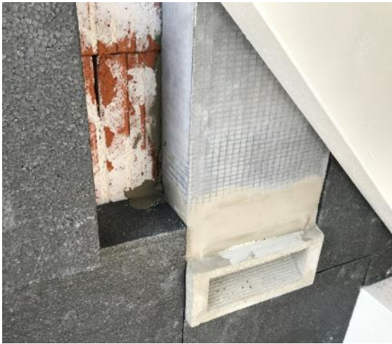
Abbildung 13: Ganzjahres Fassadennistkasten (Bildquelle: https://www.nistkasten-hasselfeldt.de/fledermaus-ganzjahres-fassadenkasten-unterputz-mit-blende#4 )
